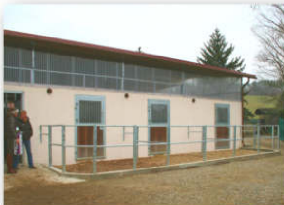
Außenboxen Mauerwerk mit Paddock
