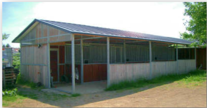
Außenboxenstall mit überdachter Stallgasse
