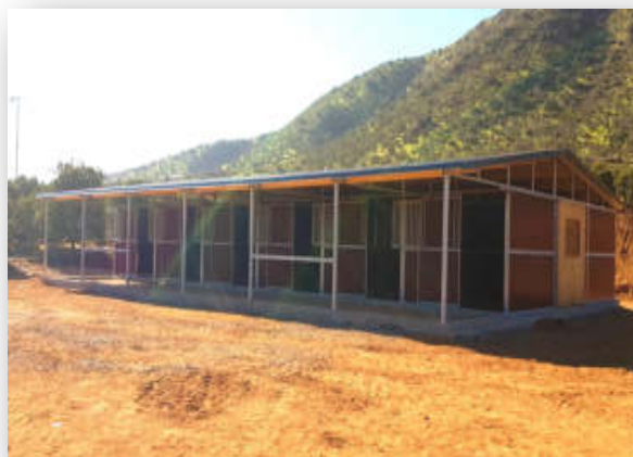
12er-Außenboxenstall m. Stallgasse vorne und hinten
